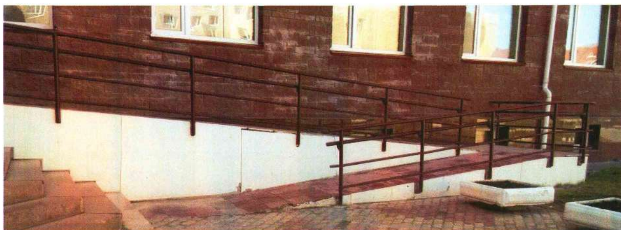
Фото №8 — Входная площадка перед дверью.
