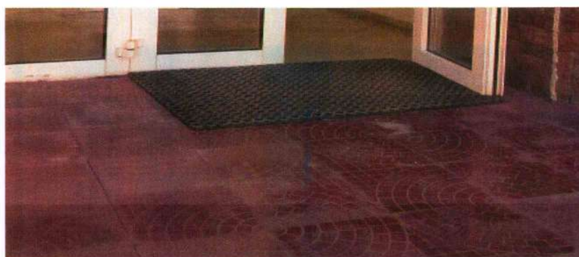
Фото №9 — Дверь входная.
